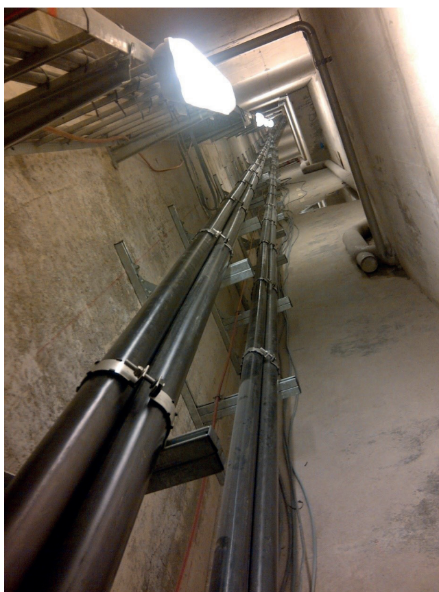
Kuva 1. Jäykkä kaapeliasennus.
