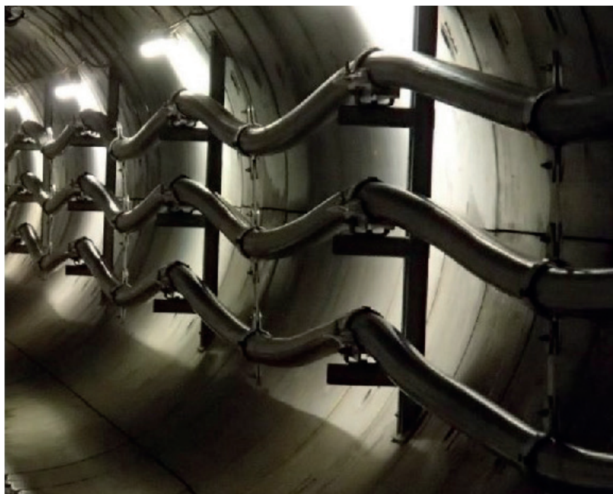
Kuva 2. Pystysuunnassa joustava kaapeliasennus (kuva: Balfour Beatty).
